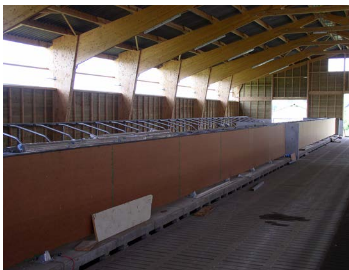
Panneau bois devant logettes. Ne pas fixer sur tubulaire des logettes pour garder la longueur nécessaire à l'animal.
