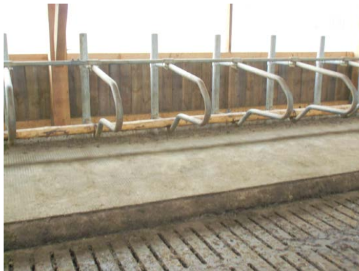
Bardage devant logettes (mur plus chaud).
