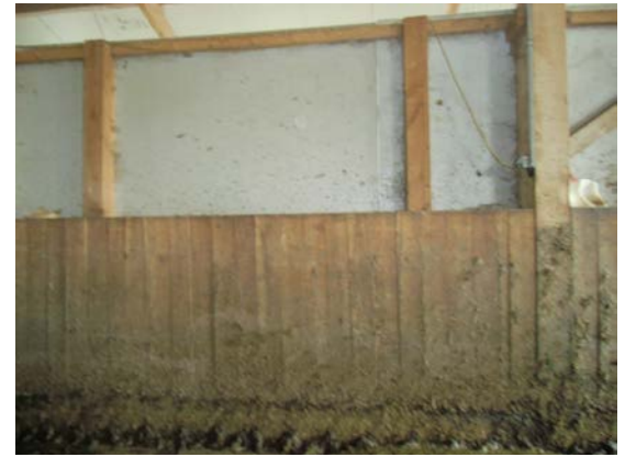
Bardage bois posé en pourtour d'une aire d'exercice
