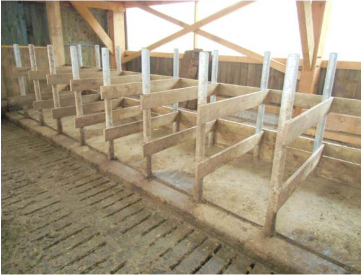
Séparation logettes génisses sevrées construite en fonction de la taille des animaux (expérience améliorable techniquement).
