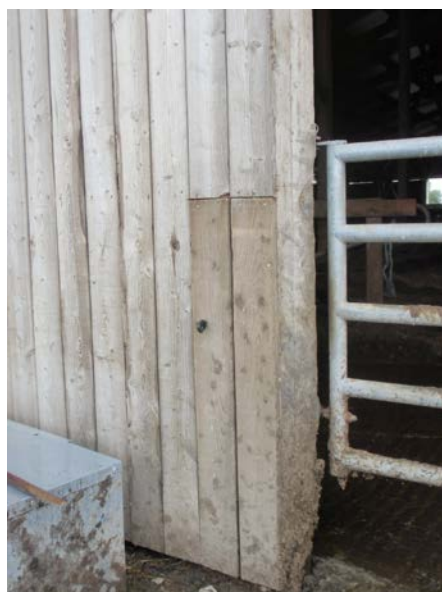
Possibilité de réparer soi-même le bardage si accrochage.
