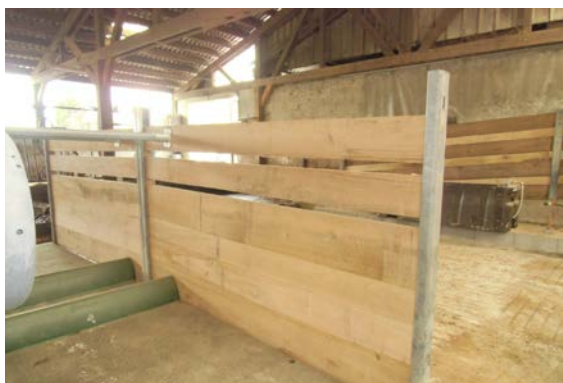
Bas-flanc de logette obligation de sceller un poteau métallique dans la maçonnerie.
