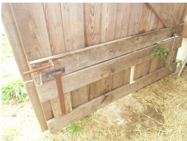
Astuce porte bois aménagée ; prévoir un trans lucide sur la partie supérieure (apport de lumière et allège par temps humide).
