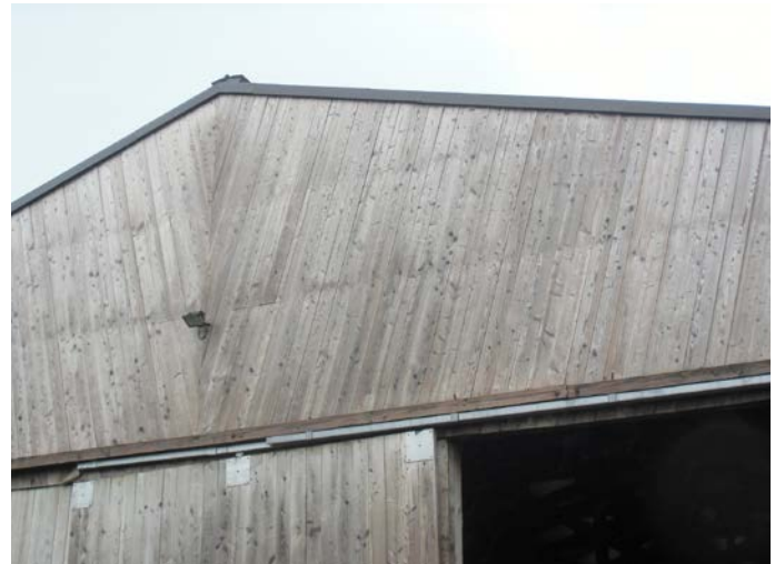
Bardage bois auto-construit (ne nécessite pas de lasure)
