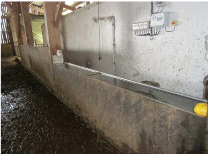
Intégration d'un abreuvoir dans un mur en bois existant.
